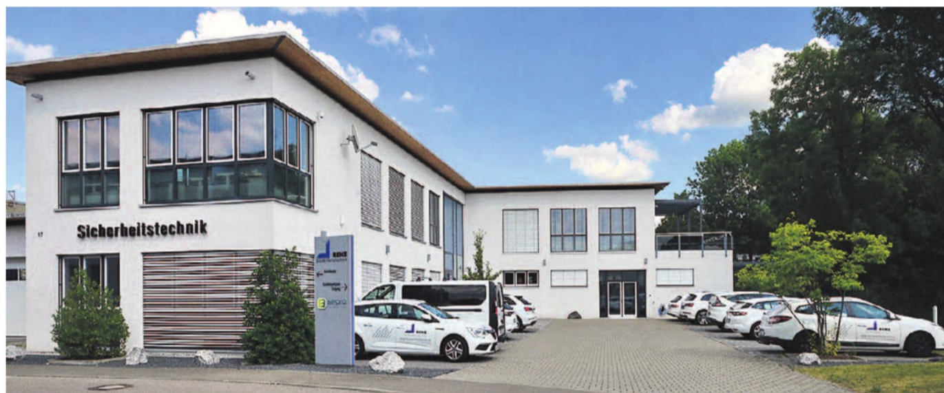
Der Neubau der Firma Renz im Eninger Gewerbegebiet Arbachtal. Foto: Niethammer
