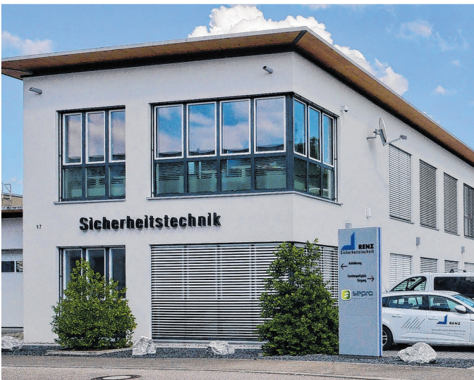
Der Neubau im Eninger Gewerbegebiet Arbachtal.
